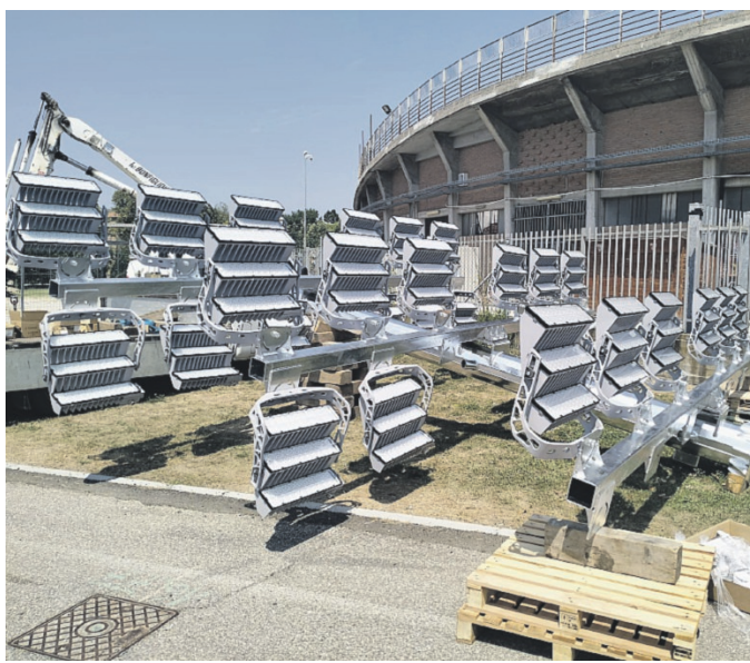
Uno dei pennacchi delle torri faro
